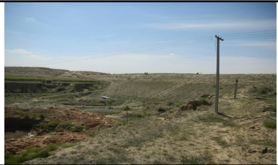
坝体下游坡现状
